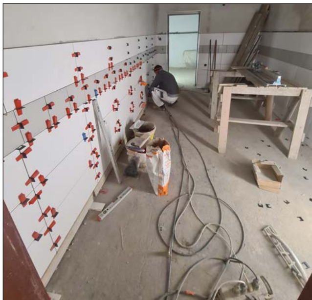
Nové šatny v prvním podzemním podlaží multifunkčního domu dostávají svou podobu. Po zednických nastoupili obkladači, sádkořádky a podlaháři. ■
