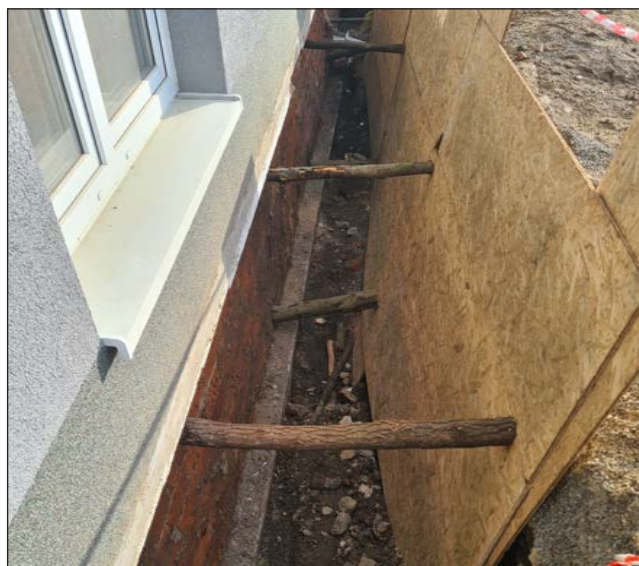
V rámci rekonstrukce prvního podlaží multifunkčního domu byly odkryty základy západního štítu. Následně budou zaizolovány proti vodě a zatepleny. Měla by tak být definitivně vyřešena vlhkost, která přes základy do objektu pronikala. ■
